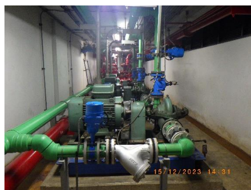
ง) เครื่องสูบน้ำดับเพลิง
