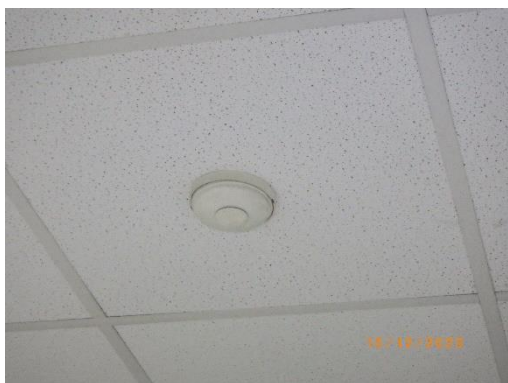
รูปที่ 11 ติดตั้งอุปกรณ์จับควัน และตัวจับความร้อน
